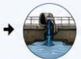
Geregelte Weiterleitung zur Kläranlage nach Ende des Regens.
